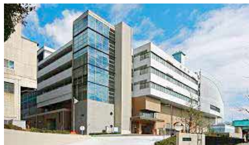
灰溶融炉を有する資源循環エネルギーセンター
