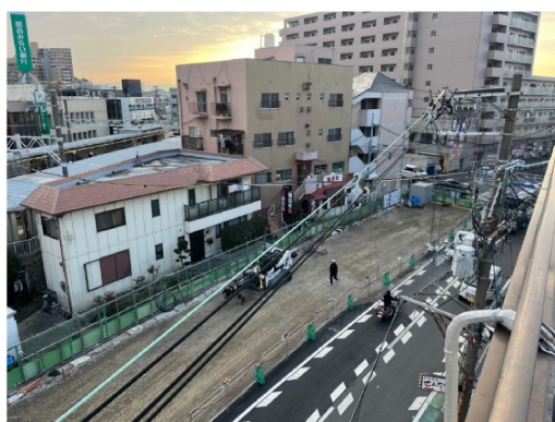
南側（上ノ川橋方向）
