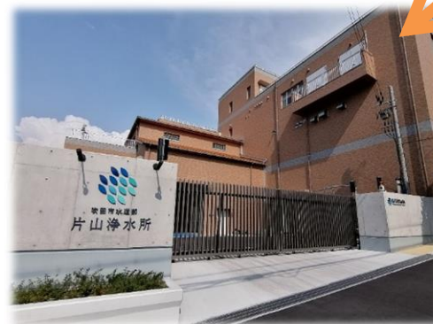
新水処理施設
