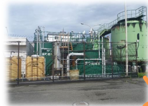
旧水処理施設
