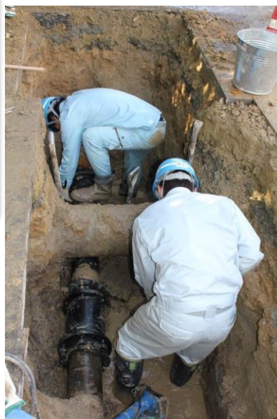
水道管の維持管理（漏水修繕）
