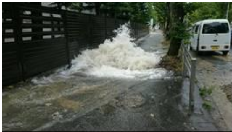
大阪府北部地震での管路の被害状況 (平成30年度(2018年度)水道技術管理者研修資料より)
