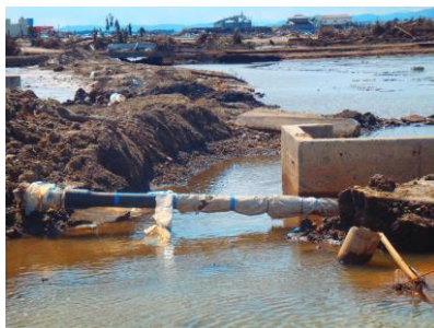
津波被害でも壊れない水道管 出典：日本ダクタイル鉄管協会
