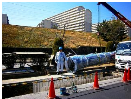
水道管布設工事
