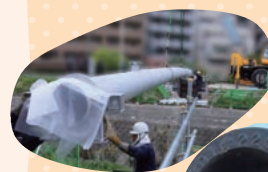
重要な管路の耐震化工事
