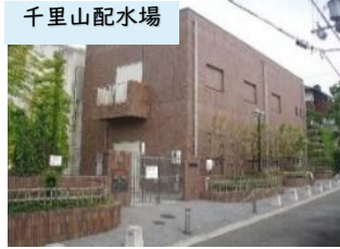
千里山配水場
