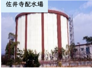
佐井寺配水場
