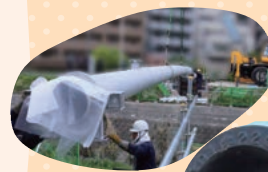
重要な管路の 耐震化工事
