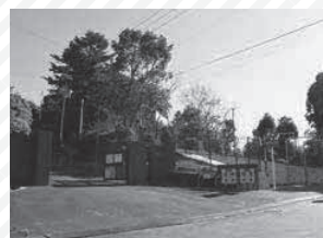
場内の配水池と水道管を耐震化 (津雲配水場)
