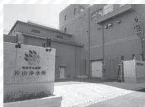
耐震基準を満たした建物 (片山浄水所)
