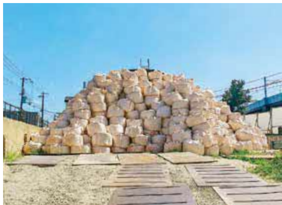
現場に設置された防護壁
