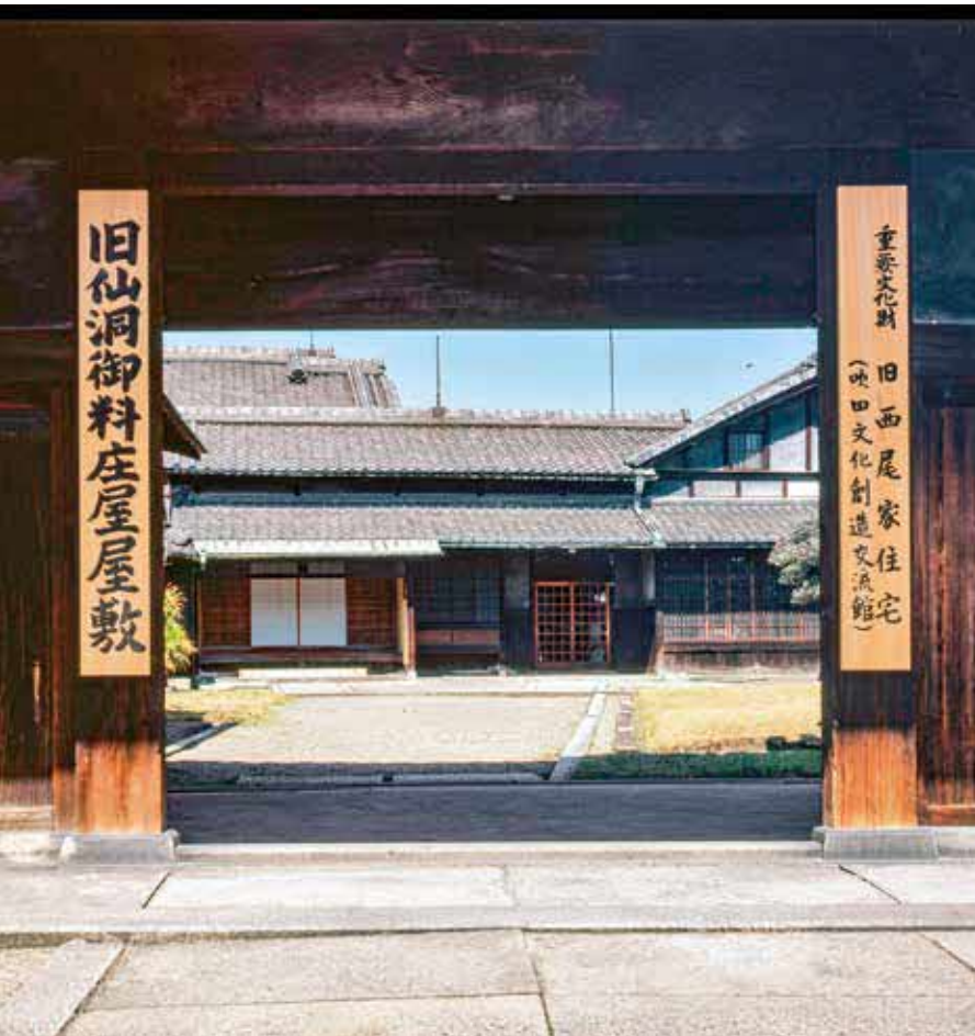
保存、修理のための工事等が行われる旧西尾家住宅
