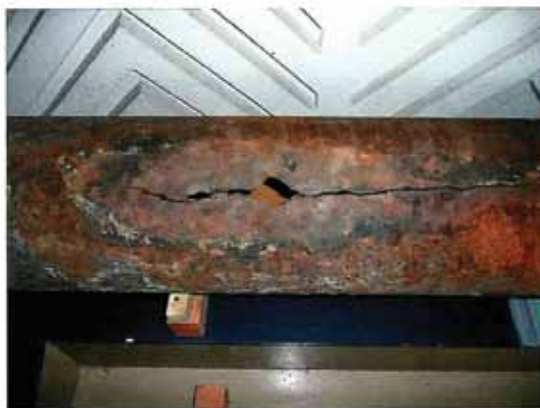
老朽化の進んだ管路
