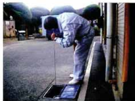
音聴棒を耳にあて漏水を調査するようす
