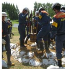
漏水に対する「釜段工法」を行う吹田市消防本部・消防団
