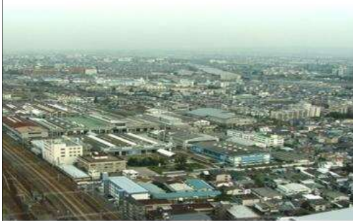
吹田総合車両所 全景
