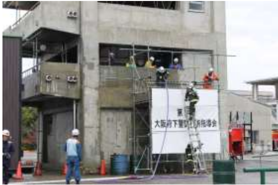
3連はしごで屋内進入する様子
