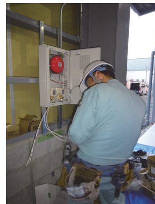
【自動火災報知設備設置工事】
