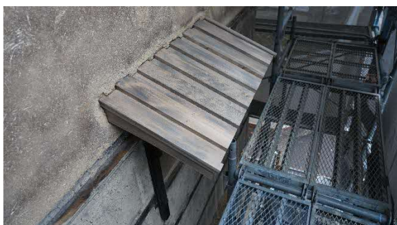
39 庇の修理 米蔵の窓庇は特徴的な形状をしています。破損が激しく、ほぼ新材に取り替えて修理しました。
