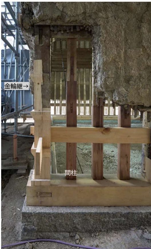
37 柱根継 足元の破損が著しかった柱に対しては、根継補修を行いました。写真の継手は金輪継と呼ばれます。また、この部分では、間柱の足元も根継を行っています。
