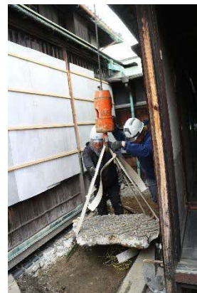
10 修理前の鴨川石敷(左写真)と解体の状況(右写真) 縁廻りの犬走は、鴨川石という京都の石を敷きつめており、旧西尾家の意匠的な特色の一つになっていますが、耐震補強工事の支障となるため、部分的に解体を行いました。敷石を一つ一つバラバラに解体してしまうと、元のかたちに戻るのが困難となるため、なるべく広く分割したうえで、クレーンで搬出することにしました。
