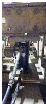
30 揚屋準備 揚屋の準備として、木材を井桁に組んだ「槽」の上に、荷重をかける H 形鋼や木部に力を伝達するための鋼材(根がらみ材)を、建物の長手・短手の両方向に設置した状況です。
