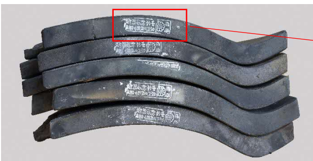
27 屋根瓦調査 棧瓦刻印 瓦の中には製造業者を示す刻印が残っているものもありました。
