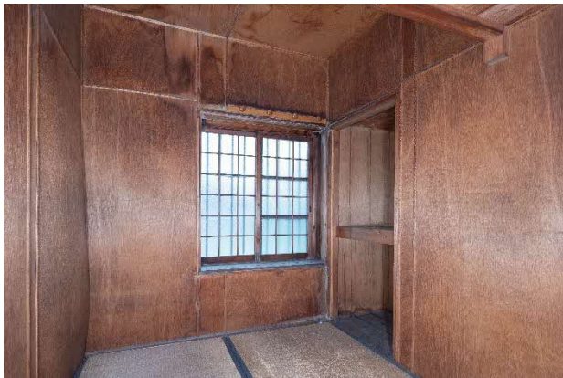
15 物置 修理前 南から見る 修理前の物置は壁に合板が張られていました。
