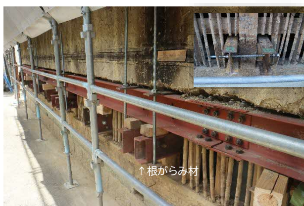
31 揚屋準備 右上の拡大写真のように、根がらみ材で木の柱を挟んで締め付けます。足元の壁を解体したのはこのためです。柱との緊結に金物は用いず、摩擦力だけで持ち上げます。
