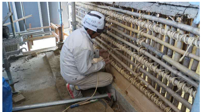
36 地覆石取替 基礎石積の1段目(地覆石)は竜山石というやや風化しやすい種類が使用されていたため、外部に面した側の劣化が進んでおり、一部、新材と取り替えました。
