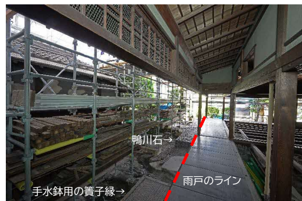
07 縁座敷 増築部分解体 東から見る
