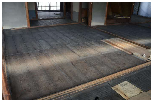
02 次の間 畳解体状況 南から見る 重要文化財の保存修理工事では、順を追って丁寧に各部材を分解していきます。
