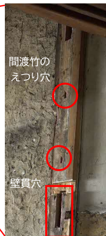
18 物置間仕切り壁痕跡 柱には壁の下地に使われる間渡竹を差し込むためのえつり穴や壁貫の穴が残っていました(右側に別の場所の壁下地の写真を参考として掲載します)。
