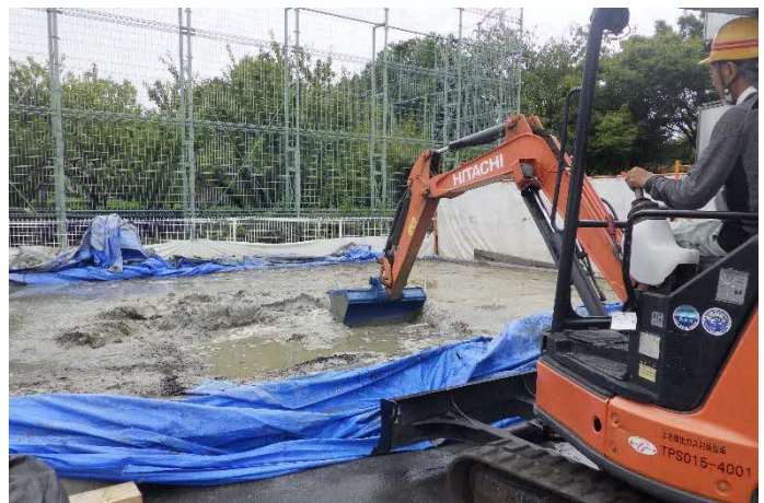
38 竹小舞復旧(上写真)と土練り(下写真) 上の写真は土壁の下地となる「竹小舞」を復旧しているところです。縦横に組み合わせた竹を藁縄で緊結していきます。また、下の写真は、解体した古い壁土に水を加え、補足土と藁を混ぜ込み、復旧に使う荒壁土を作っているところです。この土をしばらく寝かせておくと、粘り気が強くひび割れにくい土になります。
