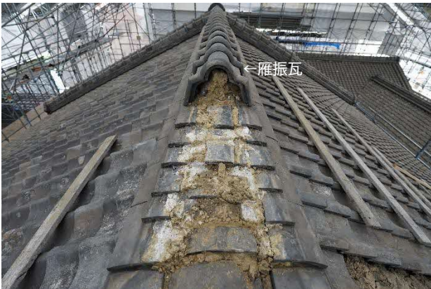
25 大棟仕様調査 大棟の断面がわかるように解体し、仕様を確認しました。旧西尾家で用いられている雁振瓦は建物の規模のわりに重厚と言えます。
