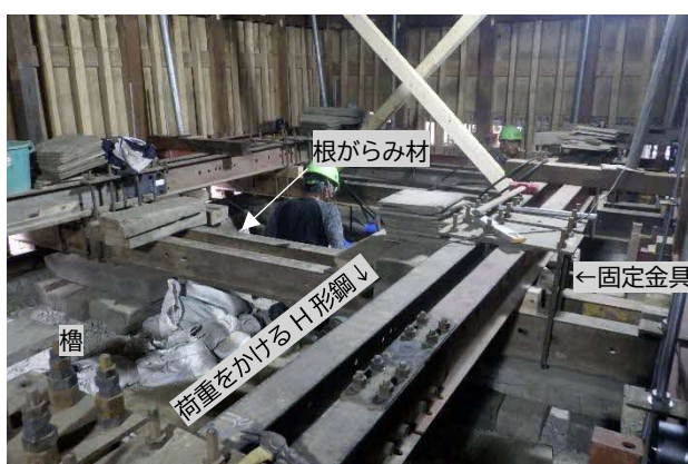
30 揚屋準備 揚屋の準備として、木材を井桁に組んだ「槽」の上に、荷重をかける H 形鋼や木部に力を伝達するための鋼材(根がらみ材)を、建物の長手・短手の両方向に設置した状況です。
