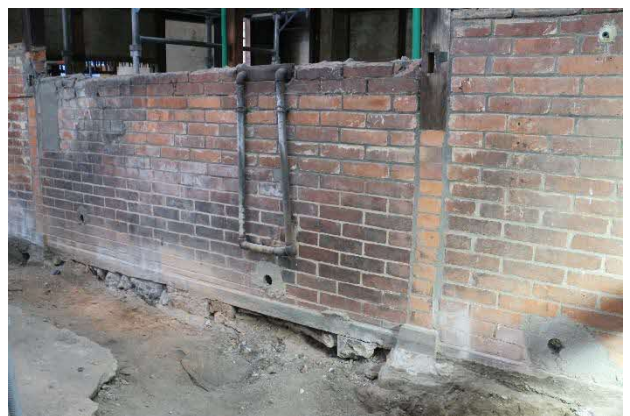
12 台所 北面外壁 土間だけでなく一部の壁にも煉瓦が使われていました。。
