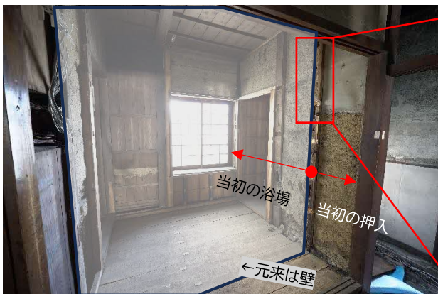
17 物置 壁合板等解体 南から見る 合板を解体すると、板絵図の状態と符合する痕跡が柱などに残っていました。写真で半透明に塗った部分は、痕跡から、元来、間仕切り壁だったと推定されます(写真18参照)。
