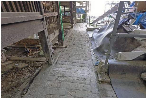
11 男部屋東側犬走り 南から見る 計量部屋から台所にかけての犬走り(軒先の土間)を煉瓦敷にしました。
