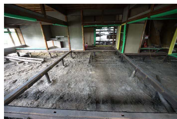
04 次の間 床組・束石解体状況 南から見る 揚屋前の解体はここまでとなります。
