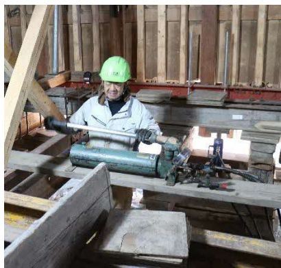
30 揚屋準備 揚屋の準備として、木材を井桁に組んだ「槽」の上に、荷重をかける H 形鋼や木部に力を伝達するための鋼材(根がらみ材)を、建物の長手・短手の両方向に設置した状況です。
