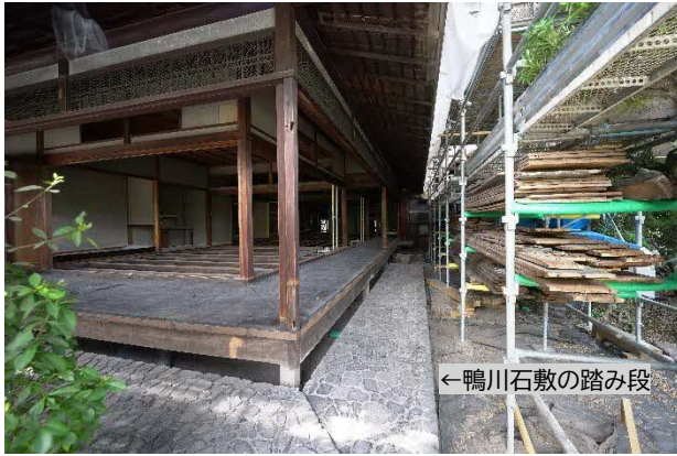
08 縁座敷 増築部分解体 西から見る 増築部分を解体した縁座敷を外側から見ています。かつては開放的な縁側であったことがうかがえます。
