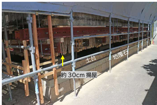
33 揚屋作業中 最終的には約 30cm 持ち上げて、土台、地覆石、柱脚部を修理できるようにしました。
