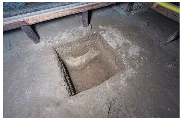
14 玄関の間 試掘調査 敷地が遺跡でもあるため試掘調査を実施し、RC 基礎新設で影響を受けるような遺構がないか確認しました。
