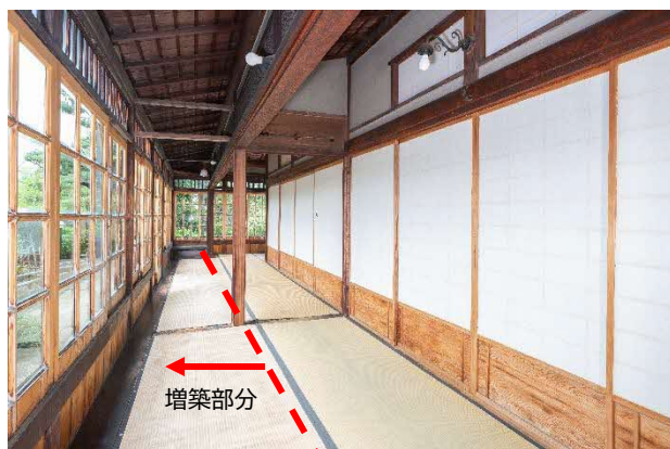
05 縁座敷 修理前 東から見る
