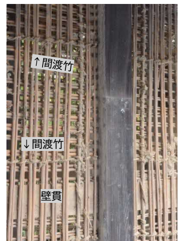
18 物置間仕切り壁痕跡 柱には壁の下地に使われる間渡竹を差し込むためのえつり穴や壁貫の穴が残っていました(右側に別の場所の壁下地の写真を参考として掲載します)。
