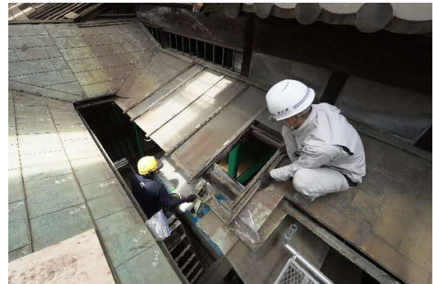
26 ナカニワ屋根 解体中 主屋の屋根は瓦葺・銅板葺のほか、ガラス板葺の部分が一箇所だけあり、慎重に解体を行いました。
