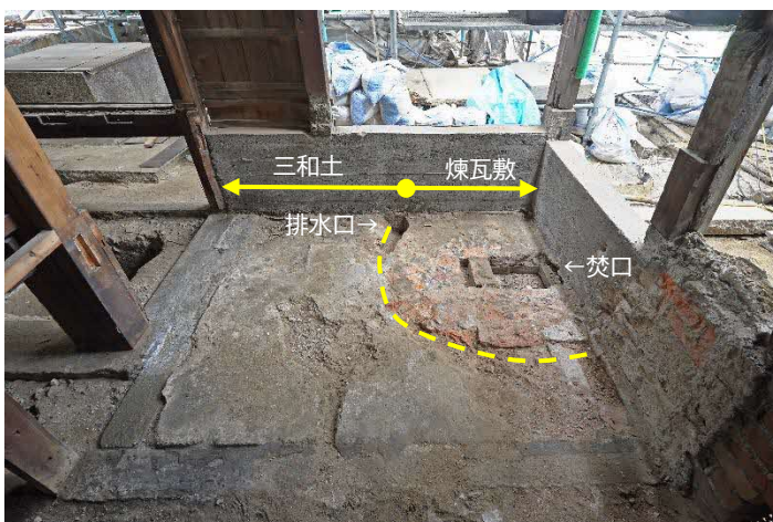
19 物置 床組およびモルタル塗り解体 南から見る
