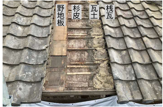
22 瓦葺仕様調査 全面的な解体に先立ち、瓦や下地の一部を筋状に取りはずし、瓦葺の仕様を確認しました。防水層に杉皮を用いるところが、この建物の特徴と言えます。
