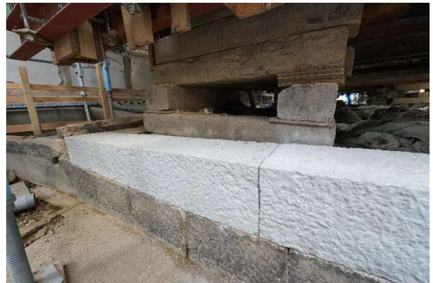
36 地覆石取替 基礎石積の1段目(地覆石)は竜山石というやや風化しやすい種類が使用されていたため、外部に面した側の劣化が進んでおり、一部、新材と取り替えました。
