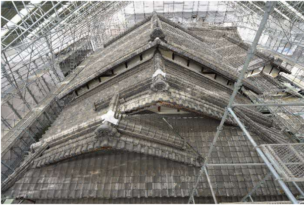
21 屋根 修理前 西から見る 修理前の屋根の状態です。妻が重なった重厚な意匠は、旧西尾家の見せ場の一つです。(周囲に見えるのは、工事中の建物を保護するための覆屋で、「素屋根」といいます)
