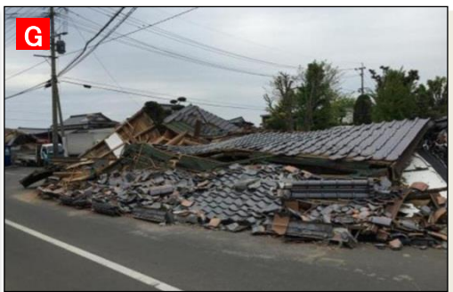
【家屋の被害(熊本市内)】 完全に倒壊してしまっていた。
