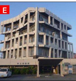
【宇土市役所の被害状況】 4階部分が潰れてしまっていた。
