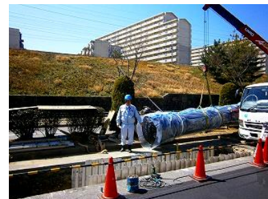
水道管布設工事
