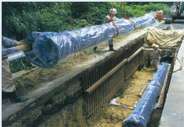
水道管の布設工事
