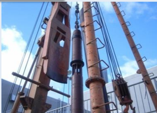
新規井戸の掘削工事
