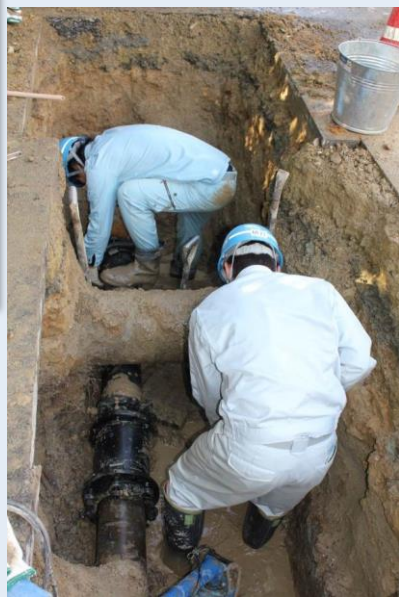
水道管の維持管理（漏水修繕）
