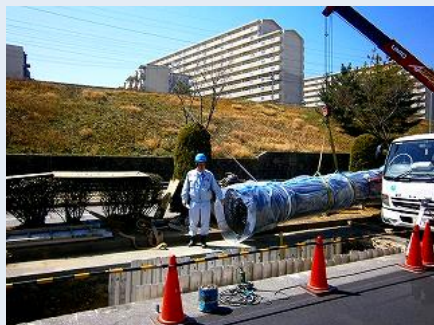
水道管布設工事
