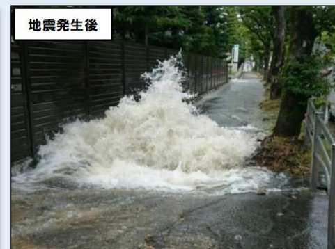
水道管の地震被害
