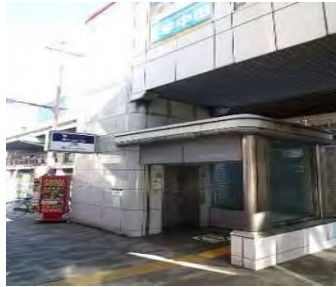
エレベーター
