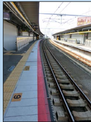
転落防止対策(くし状転落防止材の設置)
