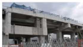
西吹田駅(仮称) 工事の様子
