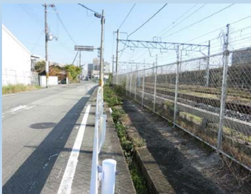
南吹田23号線の状況
