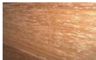
出典「木造建築物の耐久性向上のポイント」 写真 7-1 白樺による塗膜の劣化
