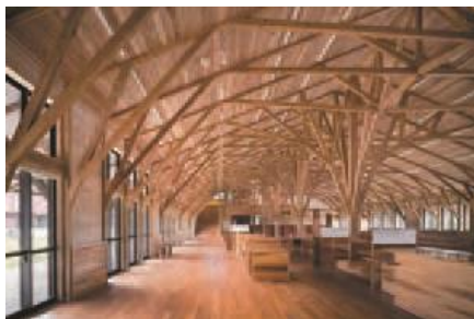
※1 ※2 屋久島町庁舎(鹿児島県) 令和元(2019)年
