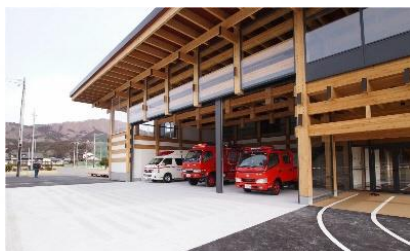
大船渡消防署住田分署 （岩手県 住田町）
