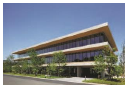
※1 新柏クリニック(千葉県) 平成 28(2016)年 (写真提供:エスエス 島尾 望)
