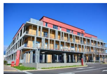
安曇野市庁舎（長野県 安曇野市）
