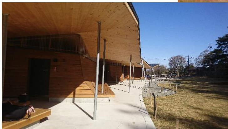
六甲最高峰トイレ（兵庫県 神戸市）
