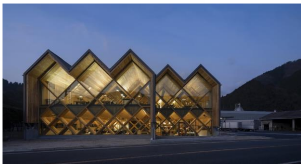
銘建工業本社事務所（岡山県 真庭市）
