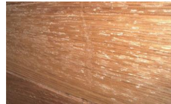
出典「木造建築物の耐久性向上のポイント」 写真 7-1 白樺による塗膜の劣化
