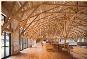
屋久島町庁舎(鹿児島県) 令和元(2019)年 ※1 ※2
