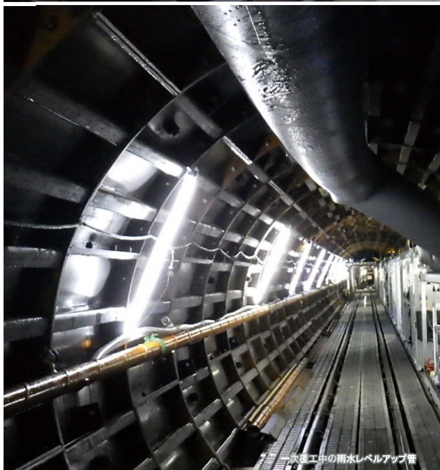
二次覆工が完了し、完成した雨水レベルアップ管
