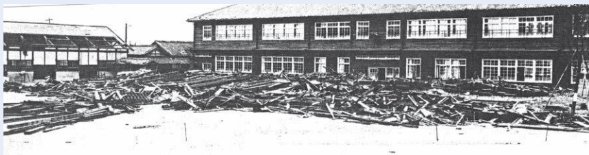
▲倒壊した校舎
