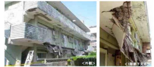
マンションの2階廊下部分が崩落した事例
