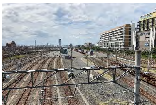
貨物ターミナルの広大な空間
