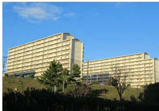
建替えられた府営住宅
