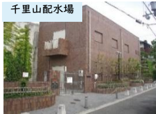
千里山配水場
