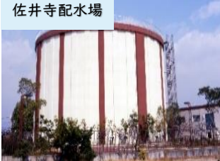
佐井寺配水場
