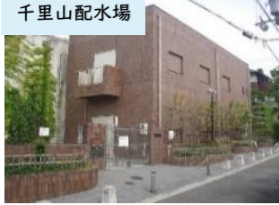
千里山配水場
