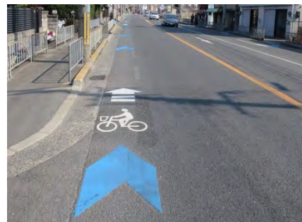
写真5-19 路面表示設置例(吹田市)
