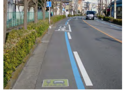
写真 5-16 カラーライン区間の例（川口市）
