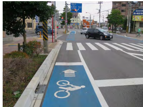
写真 5-9 停止線前出しの例(茅ヶ崎市)
