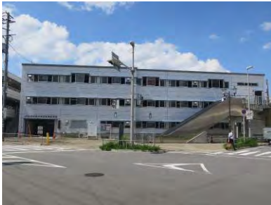
写真 3-11 階層式自転車駐車場 (JR吹田駅)
