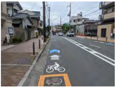
⑦車道混在（市道）片山高浜線
