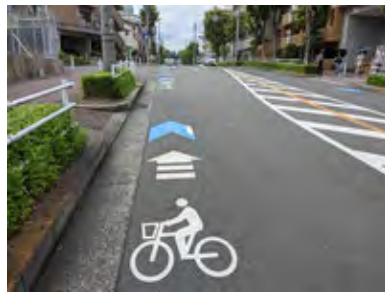
⑧車道混在（市道）千里山東朝日 が丘線
