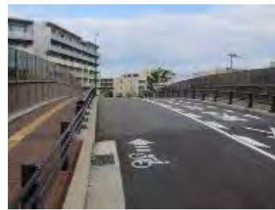
⑤ 車道混在（阪急千里山駅）
