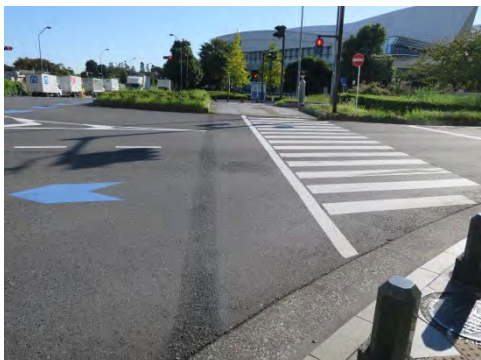
写真 5-10 自転車横断帯撤去の例 (横浜市)
