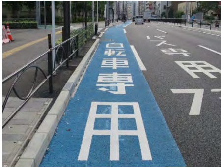
図 5-9 街渠をエプロン幅の狭い平坦性の高いものに置き換えた例（東京都文京区）
