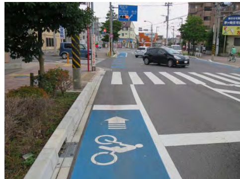
写真 5-9 停止線前出しの例(茅ヶ崎市)
