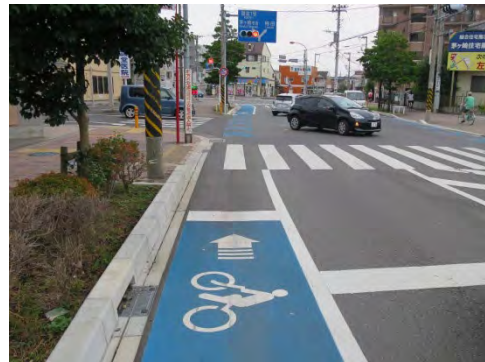
写真 5-9 停止線前出しの例(茅ヶ崎市)
