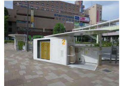
写真 3-13 機械式地下自転車駐車場 (阪急南千里駅)
