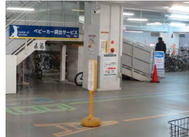
写真 5-35 ベビーカーの貸出しサービスのある自転車駐車場(武蔵野市)
