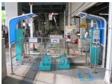
写真 5-37 機械式出入口ゲート(吹田市)
