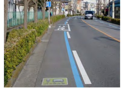
写真 5-16 カラーライン区間の例（川口市）
