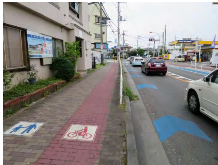
写真 5-4 車道上の自転車通行空間整備と通行位置を明示した自転車歩行者道の併用の例（茅ヶ崎市）
