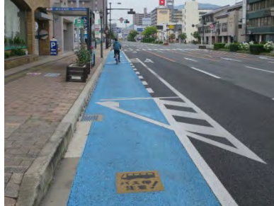
写真 5-15 カラー舗装区間の例（福山市）
