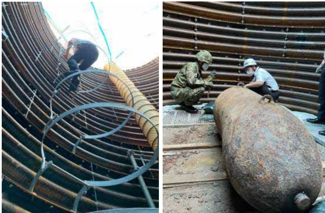
写真 1-3 不発弾処理豪の状況（令和 4 年（2022 年）7 月 13 日）
