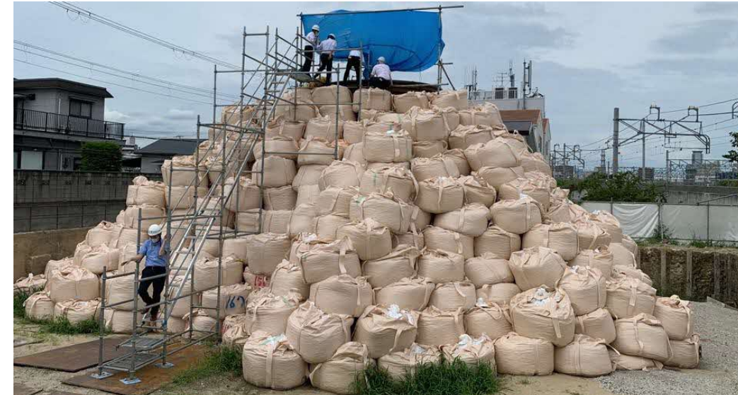
完成した処理壕
