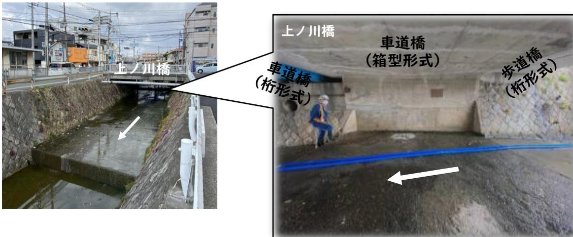
橋の下の川底を掘り下げるために、箱型形式の部分を補強します。
