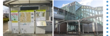
駅前広場の案内サイン・バリアフリー化の例 (JR岸辺駅)
