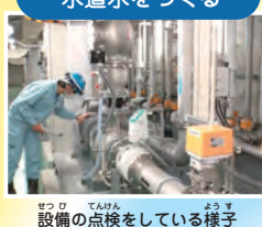
設備の点検をしている様子
