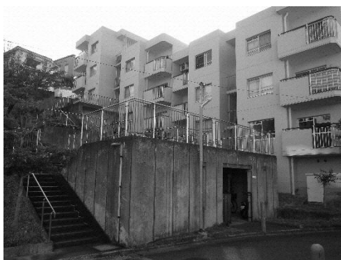
傾斜地にある住棟
