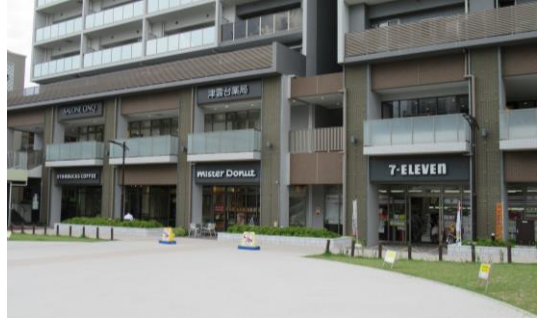
駅前のまちなみに配慮し、広告物の色や大きさ、配置を工夫した事例
