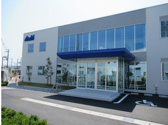
サインと庇の色を合わせ、建築物と一体的に計画した事例
