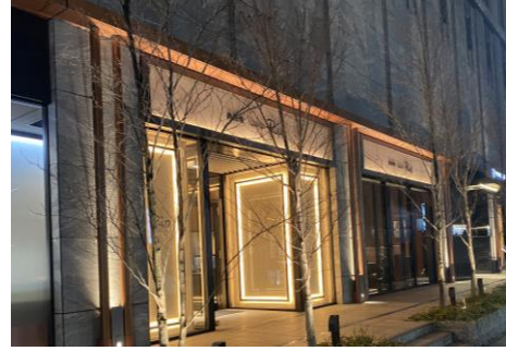
間接照明を用い、設置高さを低く抑え、色温度を統一した事例
