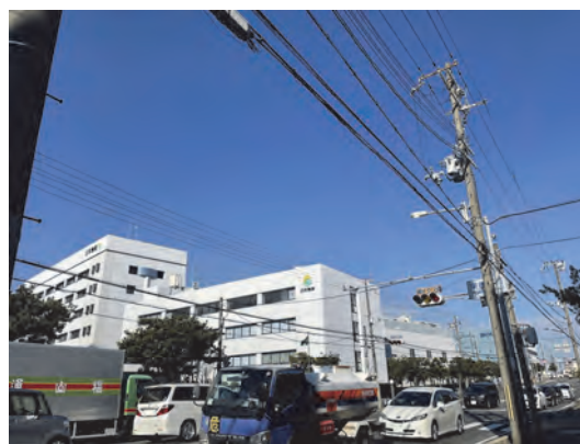
幹線道路沿いの業務施設
