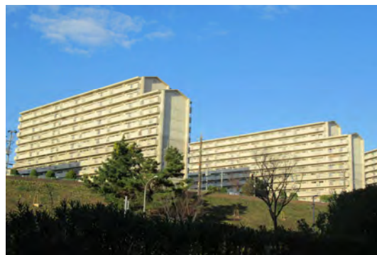
建替えられた府営住宅
