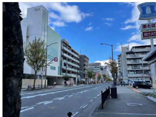
大阪内環状線（国道 479 号）
