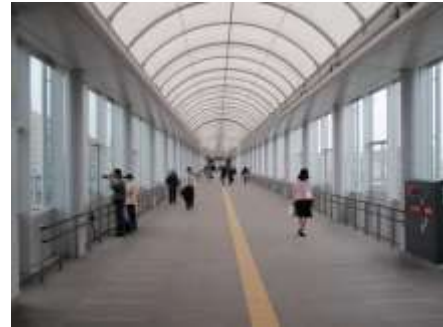
南北自由通路（内部）
