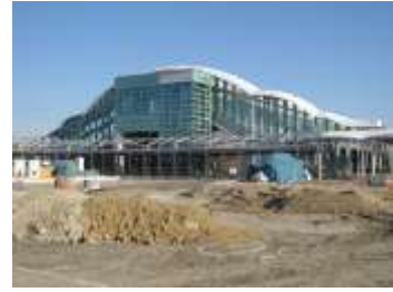
岸辺駅北駅前広場（工事の状況）
