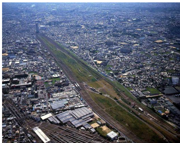
現在の吹田操車場跡地
