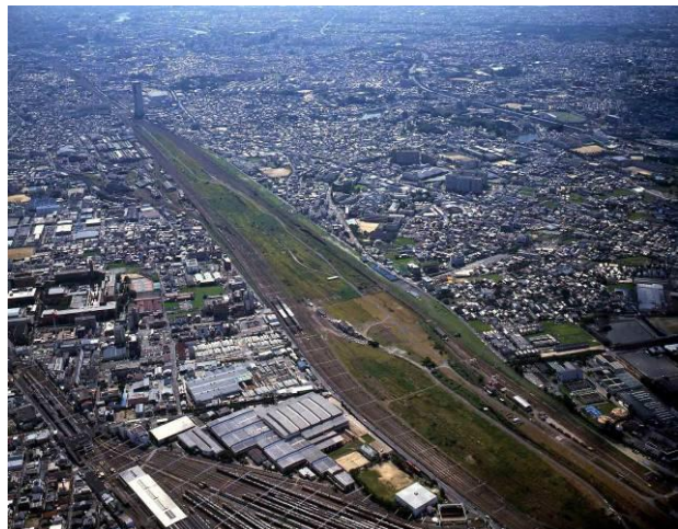
現在の吹田操車場跡地
