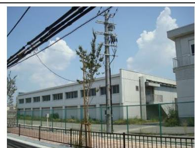
写真②：北西方より
