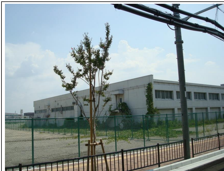
写真①：北東方より
