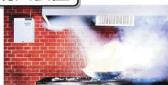
自動消火装置
